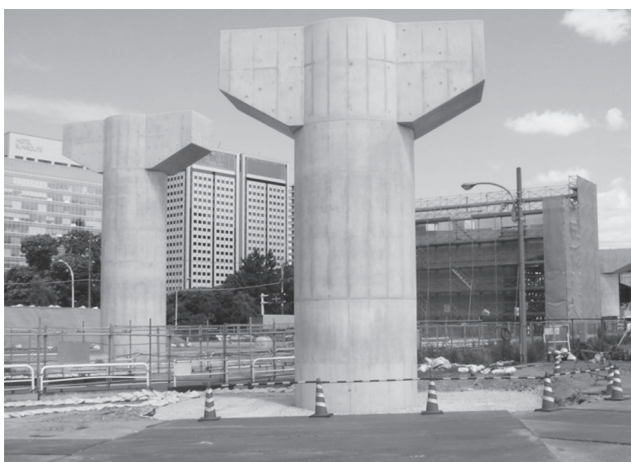
藤井建設が手掛けた高速道路ジャンクションの下部工事
