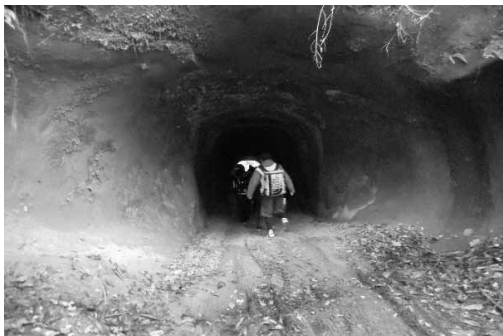
手掘りのトンネル
