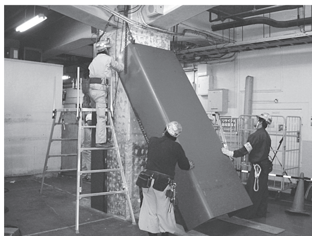
写真4 耐震改修工事
