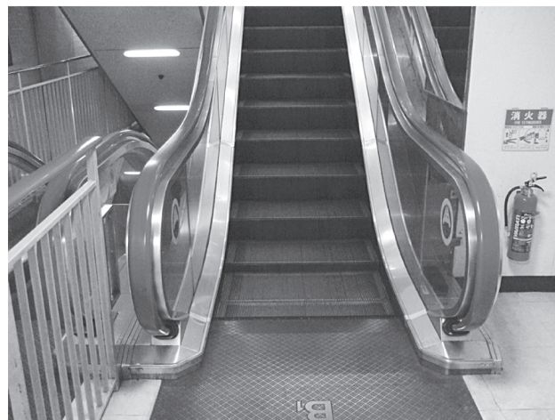
写真3 部品を第三世代に更新中のエスカレーター
